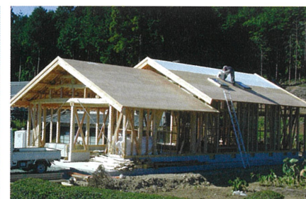
瓦屋根家屋の野地板に塗布。
