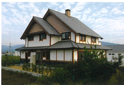
T邸：塗布箇所/屋根：300㎡、外壁：180㎡他。
