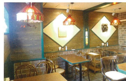
レストランの天井・壁に塗布。
