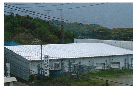
冷蔵倉庫屋根に塗布。
