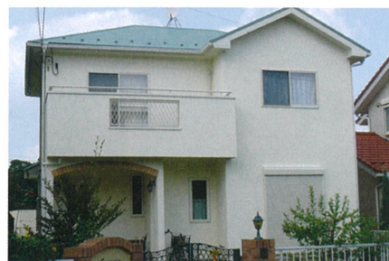
S邸：塗布箇所/屋根：94㎡、外壁：140㎡。
