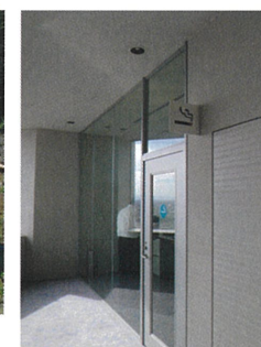
喫煙室の内壁に塗布。
