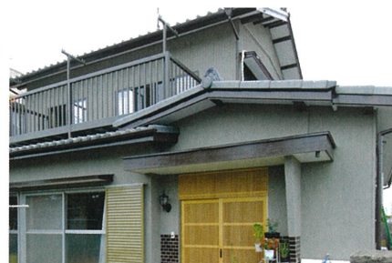
K邸：塗布箇所/内壁・天井：40㎡、外壁：260㎡。
