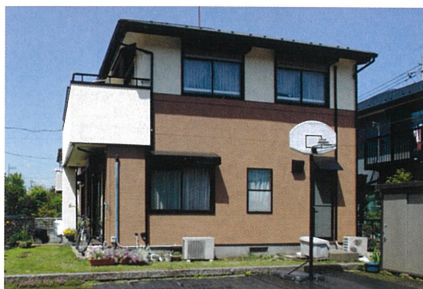
O邸：塗布箇所/屋根：90.9㎡、外壁：156.95㎡。
