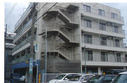
老人ホームの屋上・外壁に塗布。
