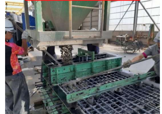
コンクリート打設
