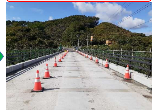
プレキャストRC床版設置完了
