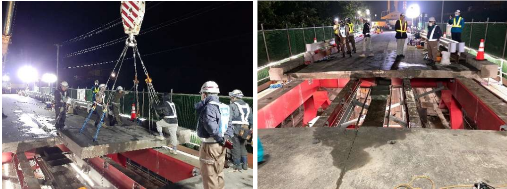
既設床版撤去
