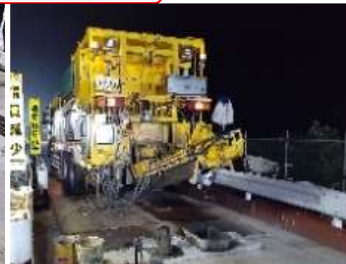
間詰部コンクリート打設
