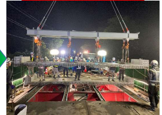
プレキャストRC床版架設
